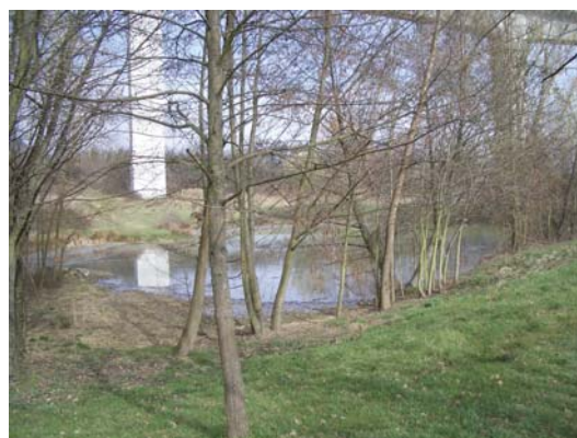
« Plan d'eau » La Robinette proche du viaduc du TGV
