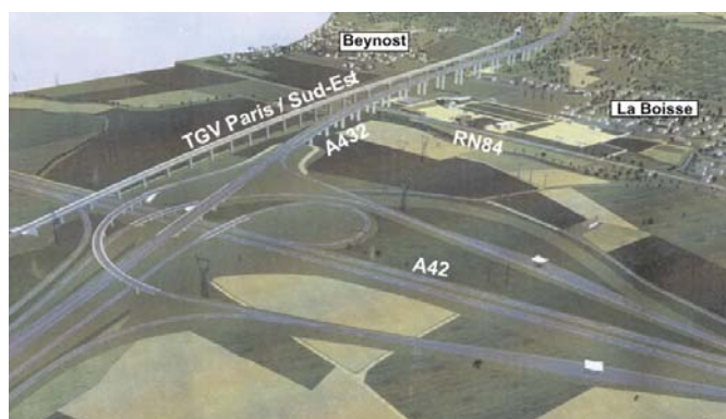
Le futur viaduc au niveau Beynost 9
